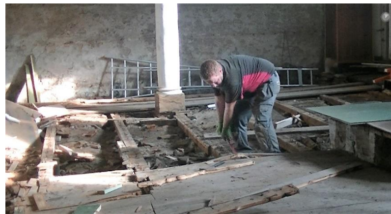
5. Het verwijderen van de vloer (foto: Siebe van Seijen)
