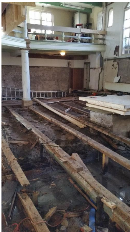
6. Alleen de vloerbalken zijn nog over (foto: Siebe van Seijen)
