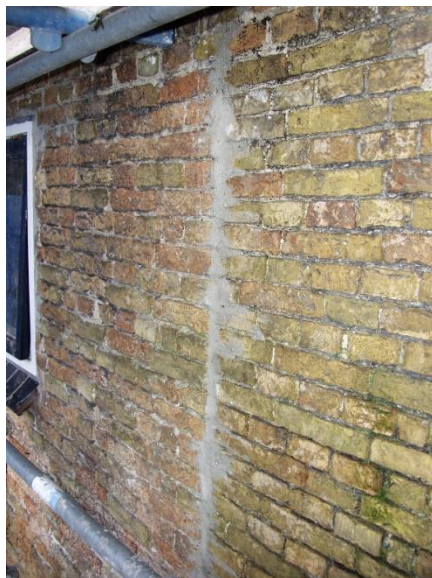
17. In de noordgevel tekent zich halverwege de kerkzaal een bouwnaad af. Dit lijkt erop te duiden dat het gebouw in drie fases is gebouwd, maar in de zuidgevel ontbreekt een vergelijkbare indicatie.
