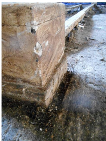
54 – 55. De bestrating rond de gemetselde basementen sluit netjes aan. Goed is bij een van de twee de verspringing te zien met de oorspronkelijke poer.
