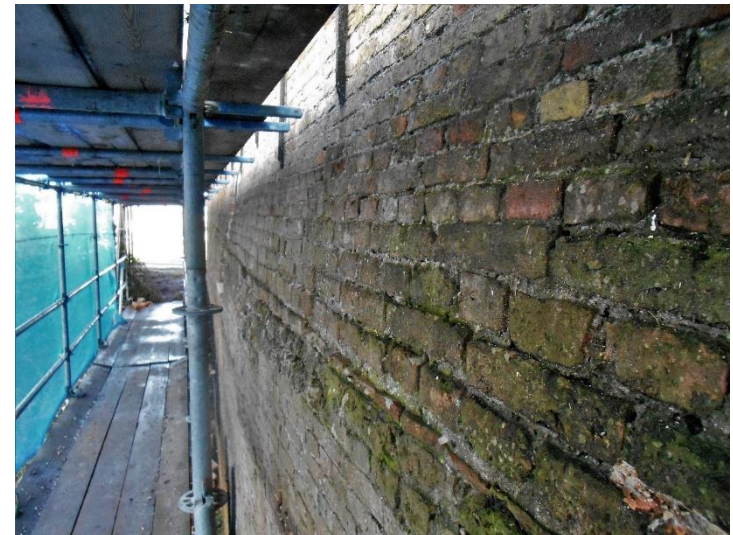
16. Het pand werd iets verhoogd en de laatste rijen baksteen van de noordgevel zijn bewust aflopend gemetseld. De reden hiervoor is onduidelijk.
