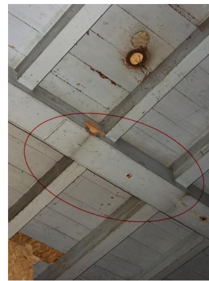
56 – 57. Op de middelste poer stonden standvinken en later pilaren die de verdieplings- en zoldervloer middenin steunden. De onderslagbalk lijkt foto fors, door de aftimmering met dunne planken maar is slechts 12 cm dik.
