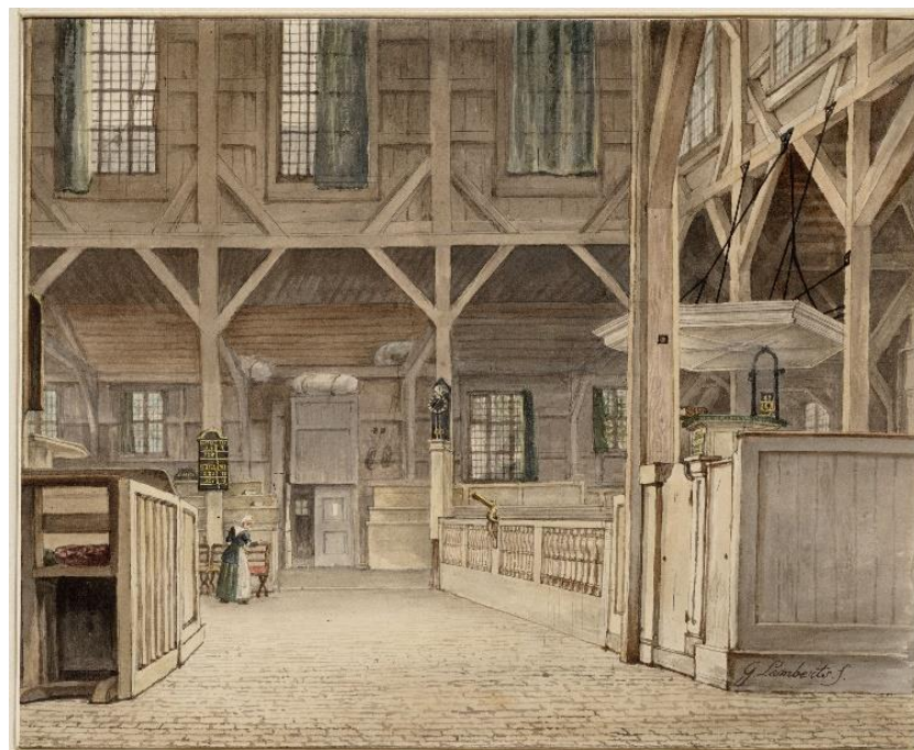
29. Ook kerken hadden geregeld simpele bakstenen vloeren, zoals de Amstelkerk, een houten 'noodkerk' op het Amstelveld te Amsterdam.
