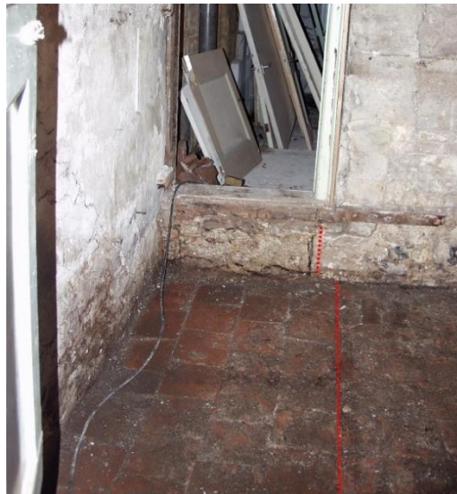
30 – 31. De vloer loopt ter weerszijde van de gracht loopt sterk naar het water toe af. Het gevolg van verzakkingen.
