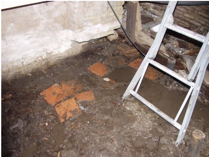
43. Op diverse plaatsen liggen tuimelaars in de gracht, soms vrij netjes in een regelmatige strook. Niet duidelijk is of ook hier ooit een bestrating lag of dat de plavuizen er voor het gemak van de timmerlieden die de houten vloer maakten zijn neergelegd.
