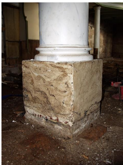
54 – 55. De bestrating rond de gemetselde basementen sluit netjes aan. Goed is bij een van de twee de verspringing te zien met de oorspronkelijke poer.
