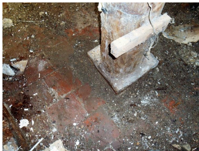
56 – 57. Op de middelste poer stonden standvinken en later pilaren die de verdieplings- en zoldervloer middenin steunden. De onderslagbalk lijkt foto fors, door de aftimmering met dunne planken maar is slechts 12 cm dik.
