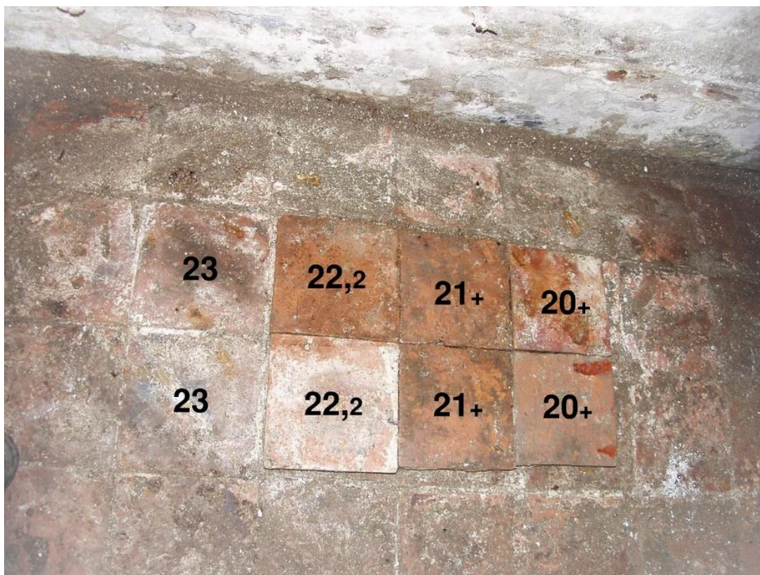
34. De tuimelaars zijn in vier uiteenlopende maten toegepast.
