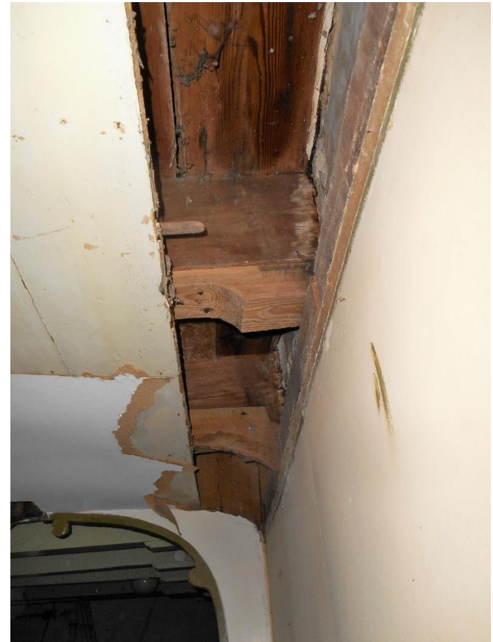
65. Achter het beschoot van de 'herenbank' is goed te zien dat de hergebruikte grenen balken en ook de bovenliggende vloerplanken door blootstelling aan het licht een veel donkerder kleur hebben dan de sleutelstukken, die nog nooit het daglicht hebben gezien en dus een veel jongere fase vertegenwoordigen.
