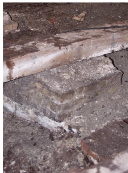
56 – 57. Op de middelste poer stonden standvinken en later pilaren die de verdieplings- en zoldervloer middenin steunden. De onderslagbalk lijkt foto fors, door de aftimmering met dunne planken maar is slechts 12 cm dik.
