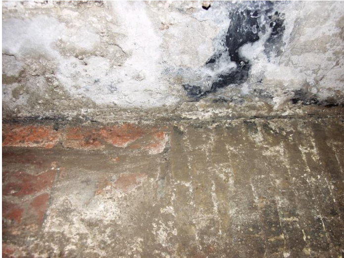
68. Helemaal duidelijk is het niet, maar het lijkt wel alsof de achtergevel óp de bestrating is gemetseld. Gezichtsbedrog of hebben we hier toch met een dichtgezette kelderruimte te maken?
