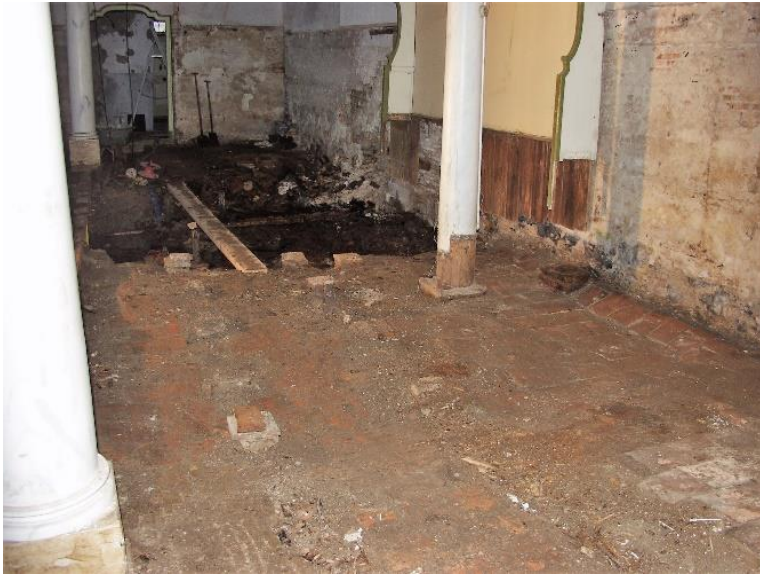
30 – 31. De vloer loopt ter weerszijde van de gracht loopt sterk naar het water toe af. Het gevolg van verzakkingen.
