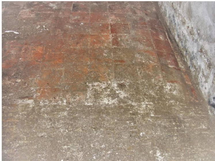
30 – 31. De vloer loopt ter weerszijde van de gracht loopt sterk naar het water toe af. Het gevolg van verzakkingen.
