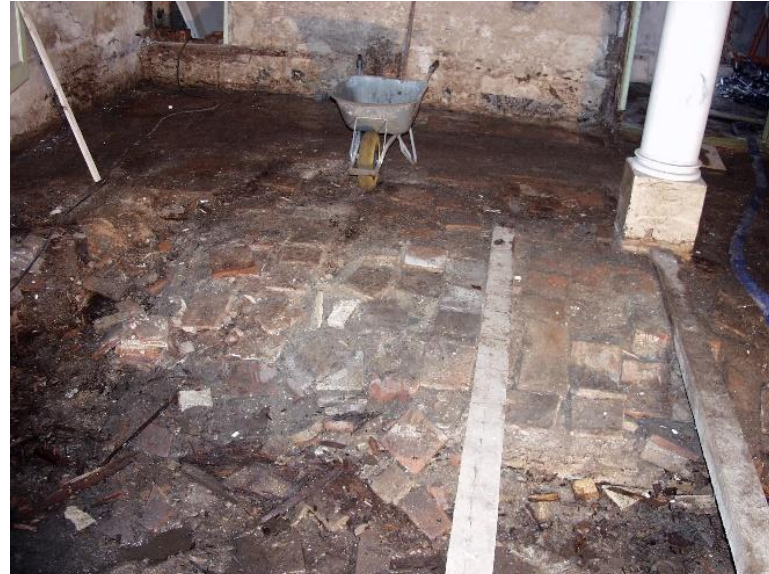
30 – 31. De vloer loopt ter weerszijde van de gracht loopt sterk naar het water toe af. Het gevolg van verzakkingen.
